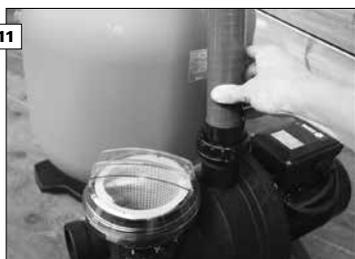
Vissez les raccords dans le filtre et la pompe. Glissez les manchons, puis les rallonges sur les deux extrémités du flexible. Repoussez les rallonges dans le raccord et vissez les manchons. (voir partie technique : 2.4.3 Raccorde-ments).
