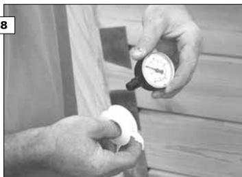
8 Appez du téflon sur le filetage extérieure du manomètre.
