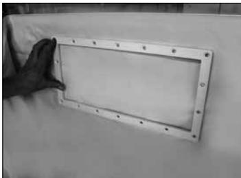
Délimitez l'emplacement du skimmer (2x) sur le liner. Collez le deuxième joint d'étanchéité du skimmer sur le liner. Faites en sorte que les trous dans le joint correspon-dent avec ceux du skimmer. Vissez-y le couvercle de finition. (vis correspondants dans la boîte du skimmer).
