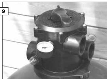
9 Dévissez ensuite le petit clapet sur le côté de la vanne et placez-y le manomètre.
