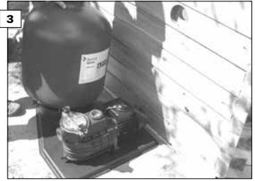
3 Placez le filtre sur le socle et remplissez le d'eau pour un tiers.
