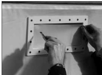
Découpez à présent le contour du skimmer. Cliquez-y ensuite la plaque de finition. Placez à présent le tuyau flexible qui se connecte au robinet (voir partie technique: 2.4.3 Raccordements) avant de continuer à remplir la piscine d'eau.
