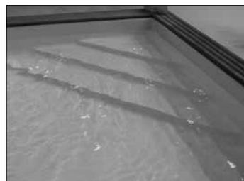
Escalier intérieur modèle angle 90° pour types H133 cm et H 146cm avec liner adapté.
