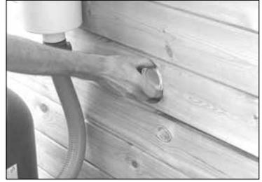
Placez à présent le tuyau flexible qui se connecte au robinet (voir partie technique: 2.4.3 Raccords) avant de continuer à remplir la piscine d'eau.
