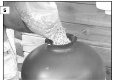
5 Versez le gravier dans le filtre (3-5mm) et ensuite le sable (0.4-0.8mm). Le sable a une durée de vie illimitée. N'ajoutez du sable qu'en cas de perte. Marquez le niveau du sable/gravier afin de pouvoir par la suite compléter au niveau voulu. La hauteur de sable ne doit pas dépasser 2/3 de la hauteur de la cuve.
