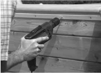
Avant d'ancrer le liner, vissez les profilés d'accrochage sur la paroi intérieure de la piscine, tous les 20 cm (vis inox 4x30 mm). Dépoussiérez les parois afin d'éviter des inégalités dans le liner. Si vous optez pour une paroi souple, vissez maintenant la pellicule à l'arrière du profilé d'accrochage ou collez aux parois. Si vous avez choisi un éclairage sous la surface de l'eau, forez
