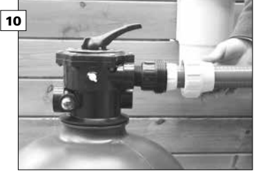
10 De pomp en filter worden met elkaar verbonden via een halfbuigzame leiding.
