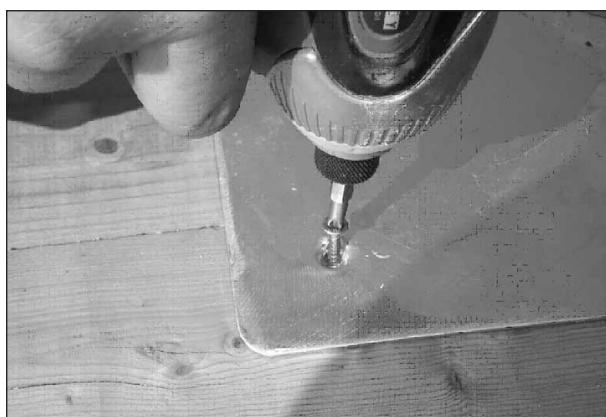
5. Plaats de plakplaat van de hemelwaterafvoer in de opening. Schroef de plakplaat vast in de houten ondergrond m.b.v. de bijgeleverde schroeven.
