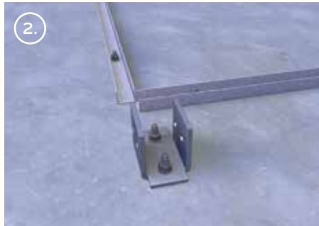
2. U-profielen bevestigen op betonplateau
