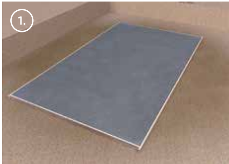
1. Betonplateau 15 cm gieten met wapeningsnet 8/8/150/150
