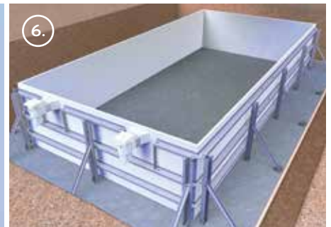
6. Liner en inbouwelementen installeren (skimmer, terugvoer)
