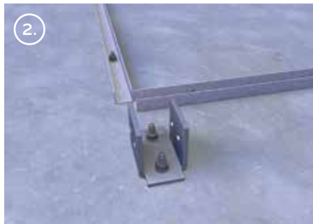
2. Fixer les profils U sur la dalle
