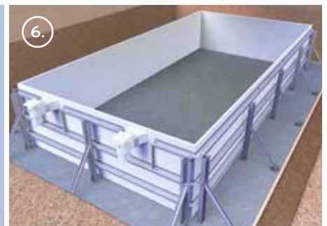
6. Installer les éléments enterrés (skimmer, refoulement)
