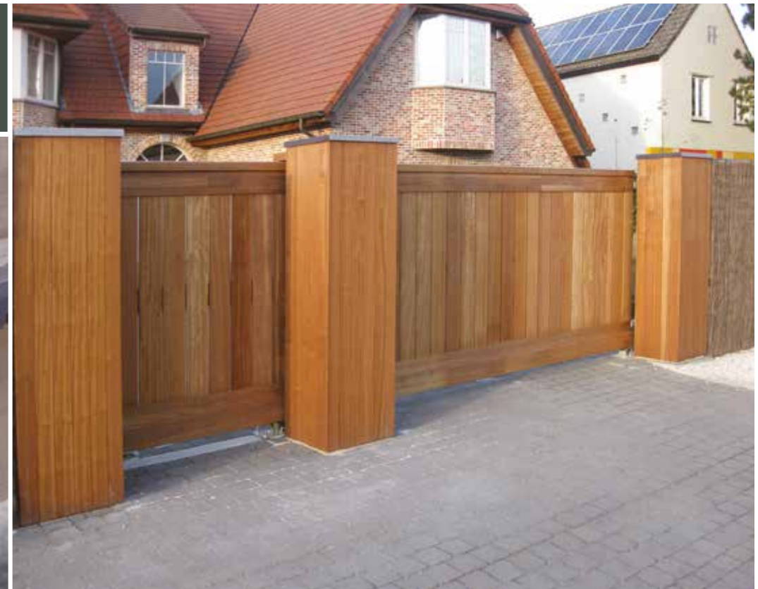
Les colonnes sont finies avec de la pierre bleue
