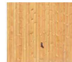
Kantelpoort met houten bekleding
